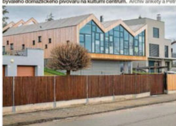
Dům Atrium Jednu z kategorií ovládl také objekt, který je určený v Plzni k bydlení. Foto: Archiv ankety ní vzhledem k jejím namátkovým kalamitacím v celostátní soutěži Stavba roku 2021.
