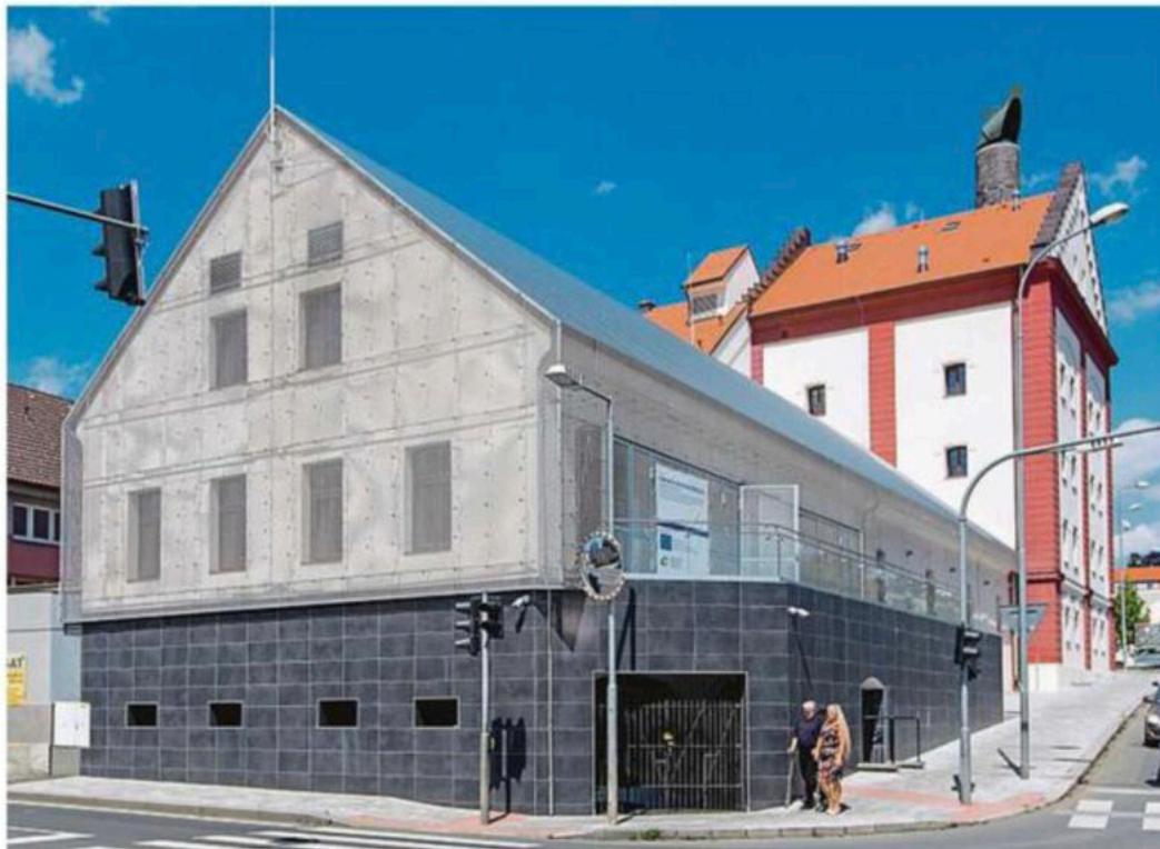
Bývalý pivovar v Domažlicích se proměnil na kulturní centrum. Rekonstrukce oslovila porotu soutěže Stavba roku Plzeňského kraje, získala tak jednu z cen.
