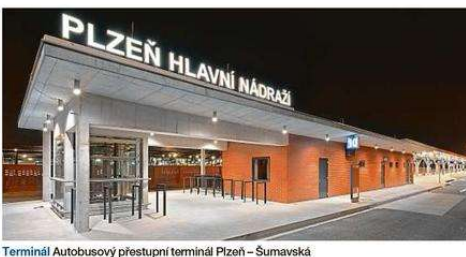
Terminál Autobusový přestupní terminál Plzeň – Šumavská
