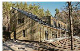
Dům u Seneckého rybníka Rekonstrukce budovy u Seneckého rybníka v Plzni Zdroj: 3x stavbarokupk.cz
