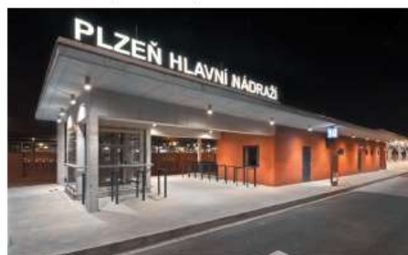
▲ Autobusový přestupní terminál v Plzni
