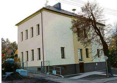
Zrekonstruovaná ZŠ v Záluží
