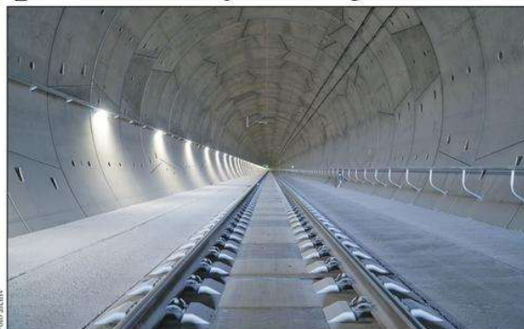
Ejrovický tunel se může nyní chlubit titulem Stavba roku Plzeňského kraje 2018.
