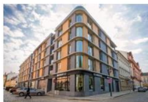
Ocenění získal i bytový dům Velešlavínova
